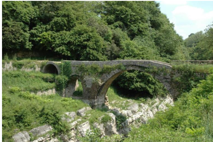
Figure 6. Ponte Fabio Massimo, Faicchio. Source: GAL Titerno.
