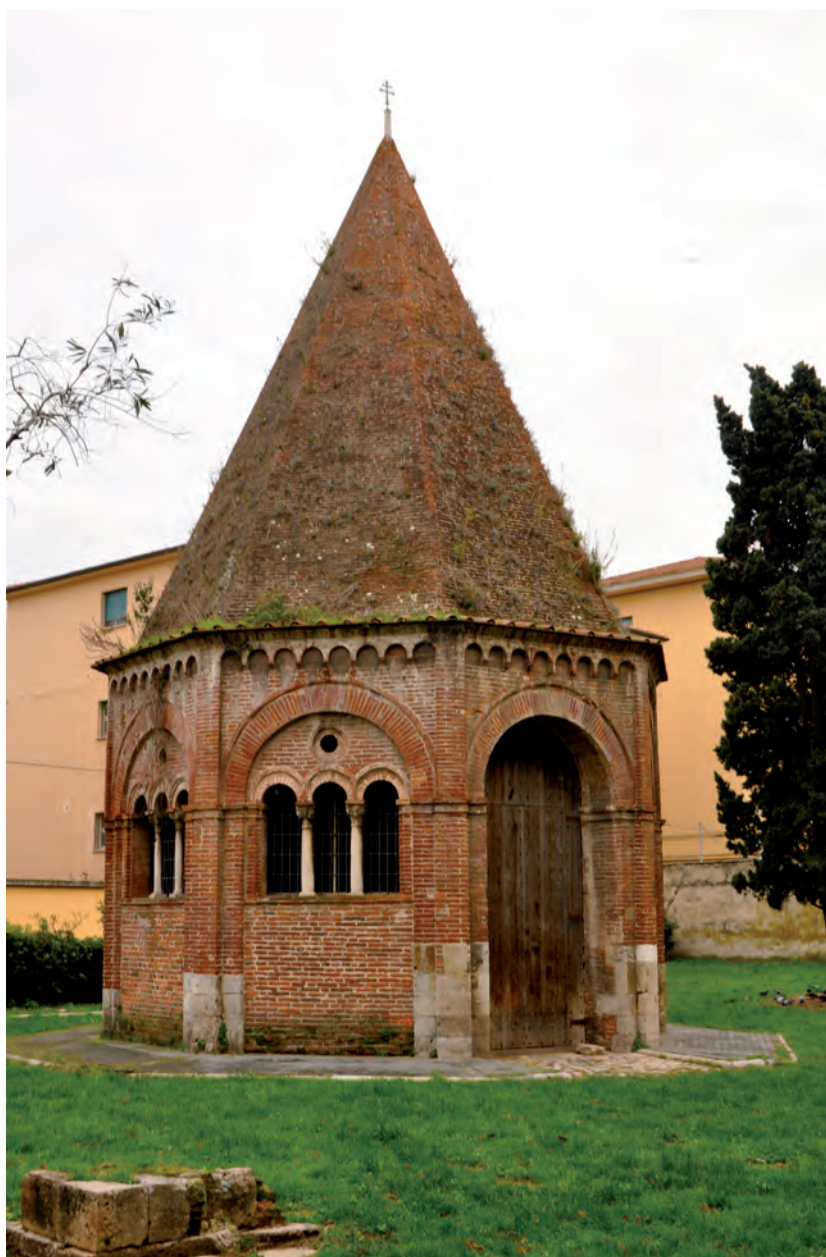
3. Cappella di Sant'Agata, vista del lato nord-ovest (foto dell'autore)
